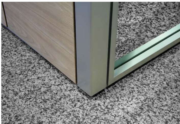
Esquina viva 90° ciego-vidrio. Angolo vivo 90° opaco- vetro. Coin vif 90° plein-vitré.
