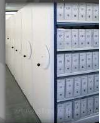
Eliminación de pasillos
